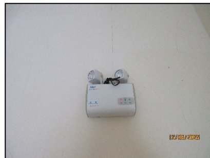
รูปที่ 40 ระบบไฟส่องสว่างฉุกเฉิน
