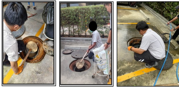
รูปที่ 11 เจ้าหน้าที่ตัดกากตะกอนไขมันออกจากถังดักตะกอนไขมัน
