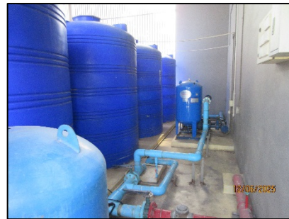
รูปที่ 37 ระบบท่อ ปลายท่อเชื่อมกับถังเก็บน้ำชั้นใต้ดิน/ชั้นคาถไฟฟ้า
