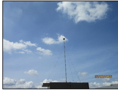
รูปที่ 26 ระบบสายดิน/ระบบป้องกันสายล่อฟ้า
