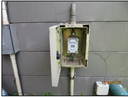
รูปที่ 26 ระบบสายดิน/ระบบป้องกันสายล่อฟ้า
