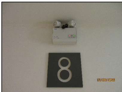
รูปที่ 40 ระบบไฟส่องสว่างฉุกเฉิน
